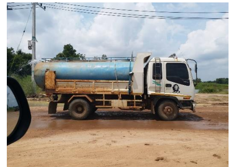
รูปที่ 2-15 การฉีดพรมน้ำบริเวณทางเข้าพื้นที่ก่อสร้าง
