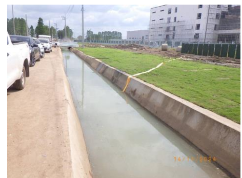
รูปที่ 2-13 รางระบายน้ำภายในโครงการ
